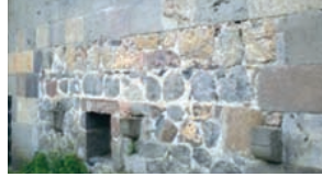
Şekil 4. Doğu cephesinde düzgün kesilmemiş taşlarla oluşturulan örgü
