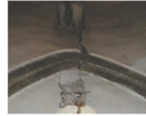
Şekil 7. Kemerlerin kilit taşları civarında meydana gelen hasar
