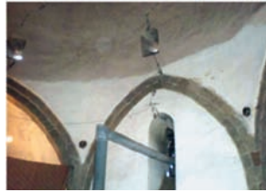
Şekil 6. Kubbenin alt kısmında meydana gelen açılmalar
