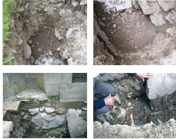
Şekil 2. Taşıyıcı yığma duvar tabanında açılan araştırma çukurları
