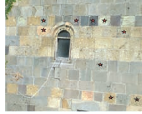
Şekil 5. Bir cephedeki çok farklı özelliklere sahip taşlar
