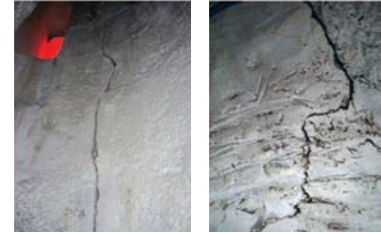
Şekil 8. Minarenin iç kısımlarında meydana gelen çatlaklar
