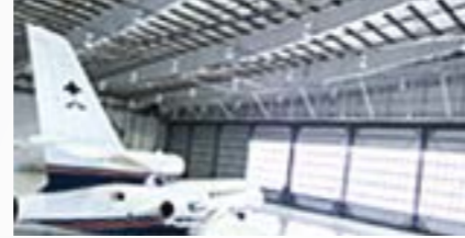
Hava Alanı Hangarları
